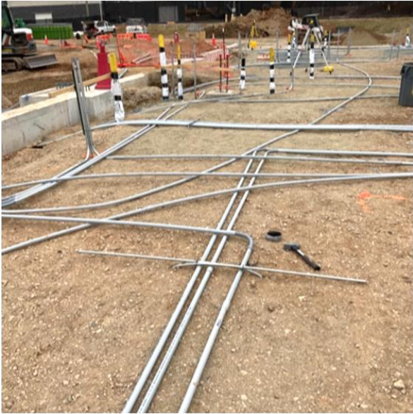
Area 1 Underslab Conduit
