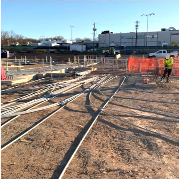
Area 2 Underslab Conduit
